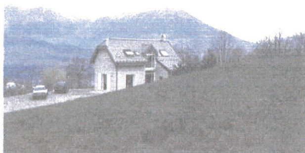
VUE GENERALE SUD-OUEST
